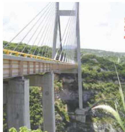
Puente Barranca El Cañon Autopista México-Acapulco
