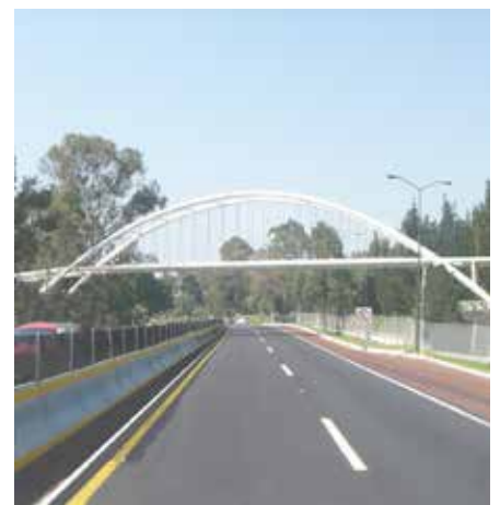
Pasarela Peatonal Tlalpan Autopista México-Cuernavaca
