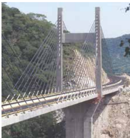
Puente Quetzalapa, Autopista México-Acapulco
