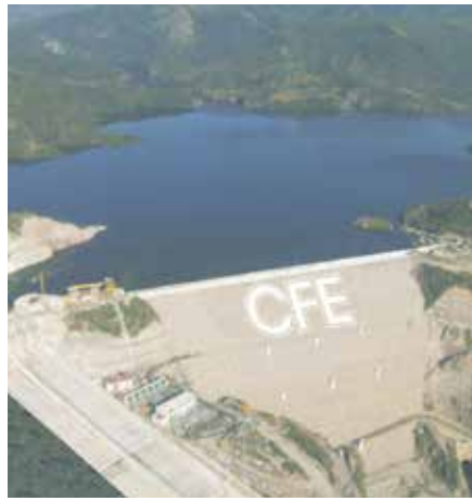
El Cajón, Dam Nayarit
