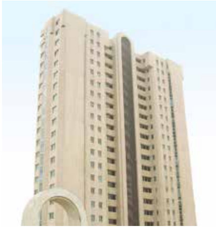
Torre Giralta México D.F.
