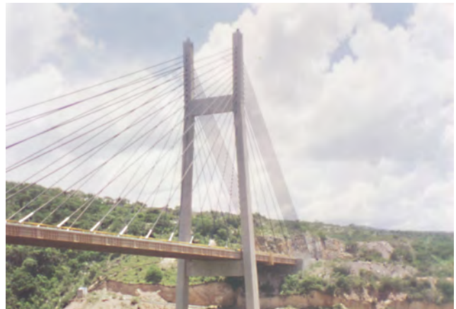
Puente "Barranca El Cañón" Autopista México-Acapulco.
