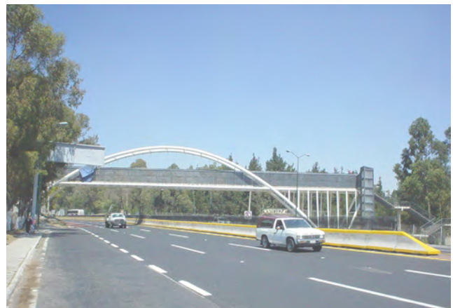
Pasarela Peatonal Tlalpan, Ciudad de México
