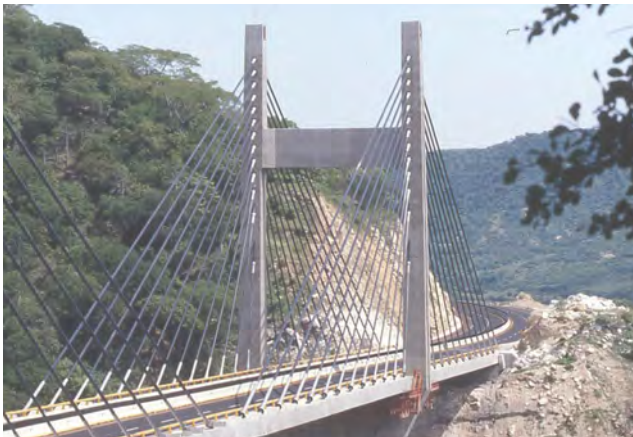
Puente "Quetzalapa" Autopista México-Acapulco.
