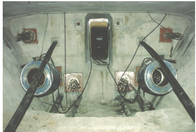
Monterrey Subway, Nuevo León.
