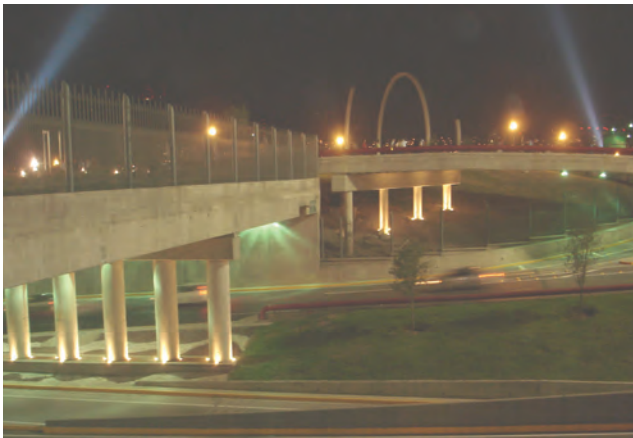
"Santa Lucía" Channel Bridge, Monterrey, N.L.
