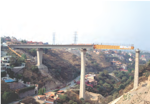
Huixquilucan Bridge, Edo. México
