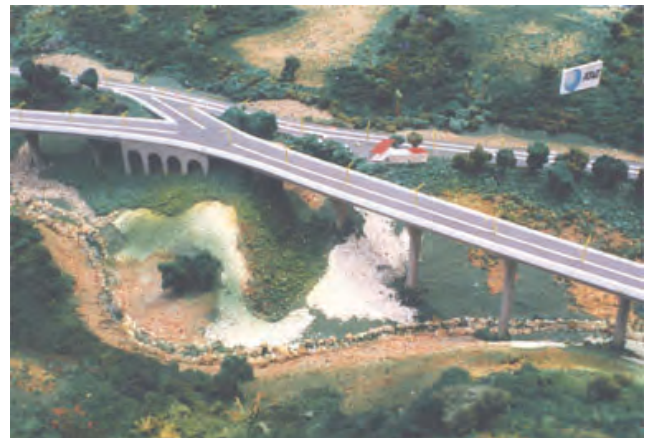
Viaducto Tacagua, Venezuela
