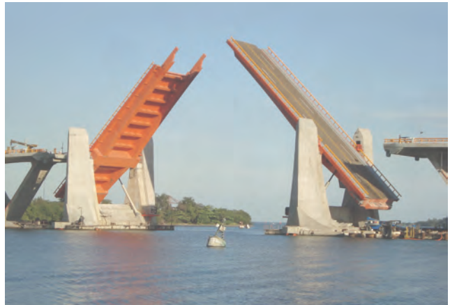
Albatros Bridge, Lázaro Cárdenas, Michoacan
