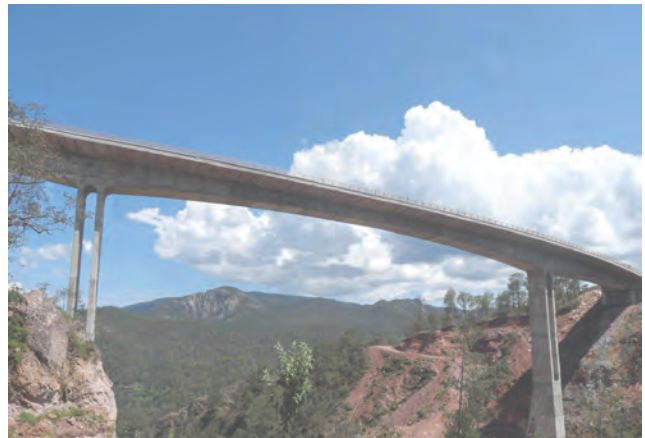
Paso de Piedra Bridge, Durango-Mazatlán Highway
