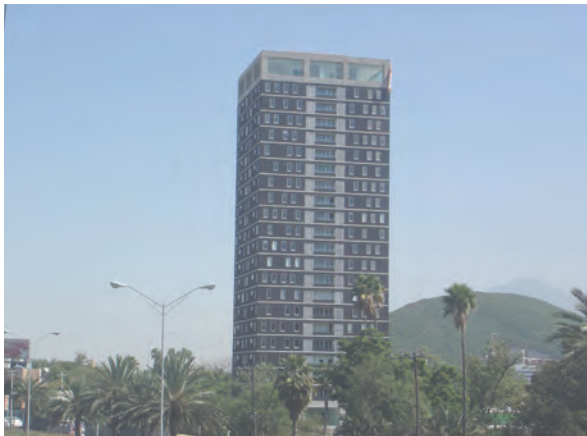
Horizontes Díaz Ordaz Building, Monterrey, Nuevo León.
