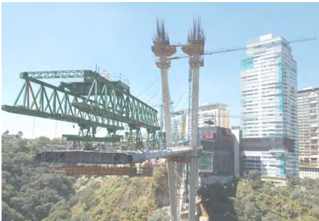
Puente "Vidalta", México D.F.
