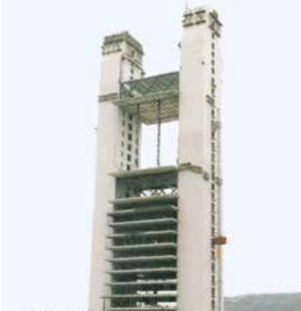
Torre Dataflux Monterrey
