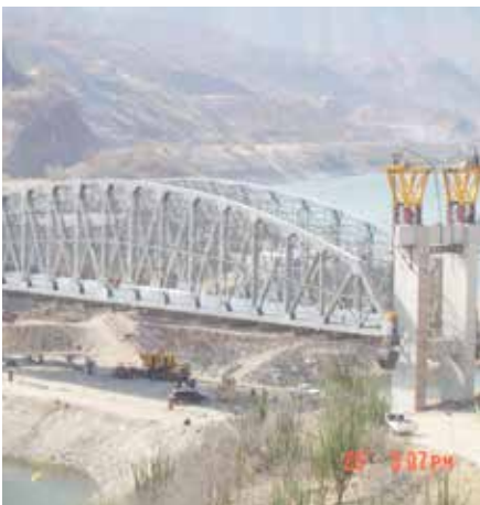
Puente Infiernillo 1 Autopista Morelia-Lázaro Cárdenas
