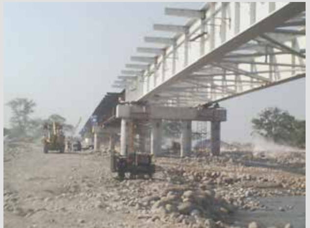
Martínez de la Torre Bridge, Mexico
