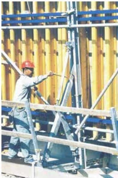
La cimbra puede ser colocada en la posición deseada rápidamente y sin esfuerzo con el husillo de acción de tijera.
